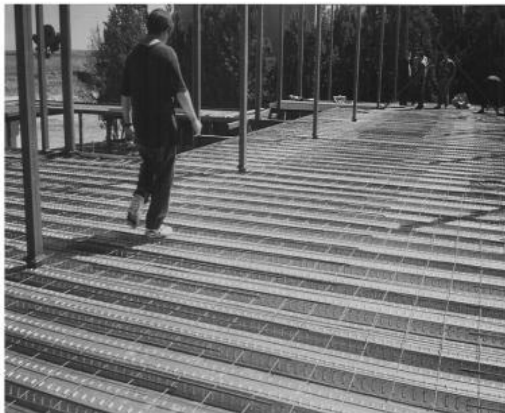
Vista general de forjado de chapa nervada colaborante.
